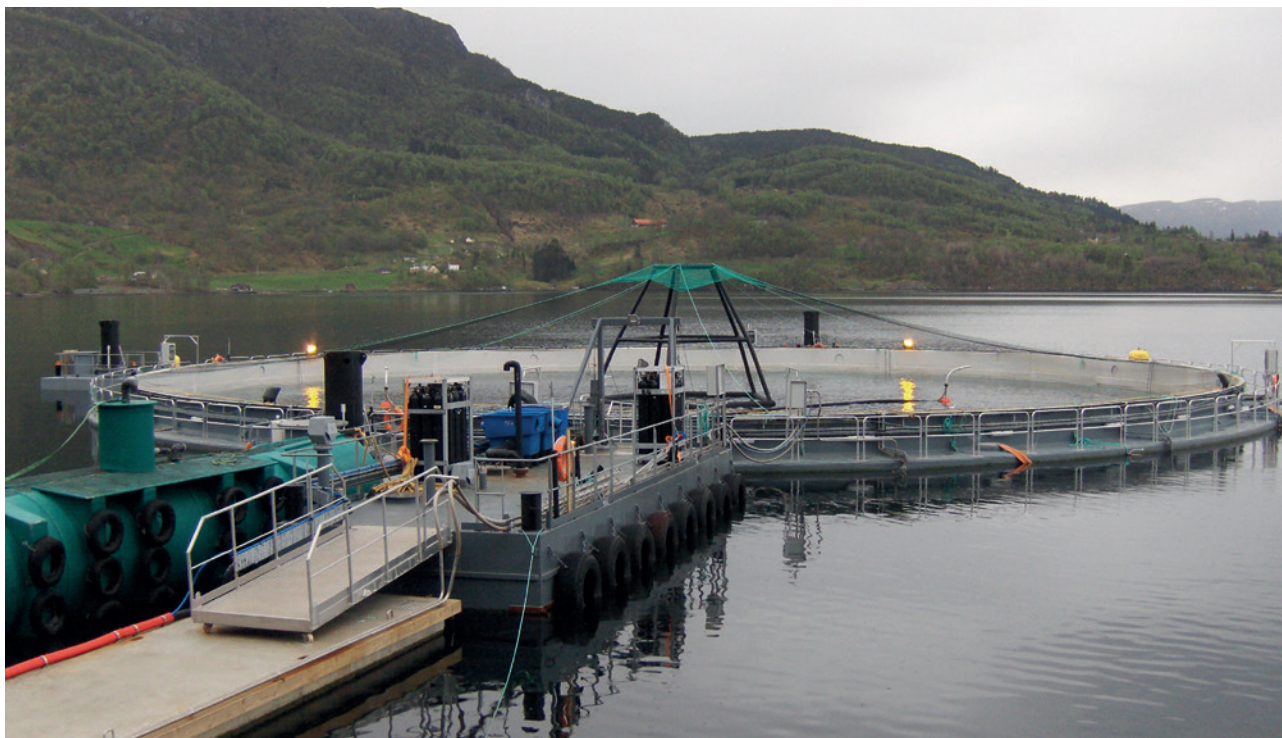
Halvsluten odlingsanläggning. Konstruktionen gör det möjligt att samla in nedfallet ifrån odlingen. Foto www.aquafarm.no
